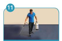
При необходимости произвести предварительное увлажение коврового покрытия с помощью ручного распылителя.
